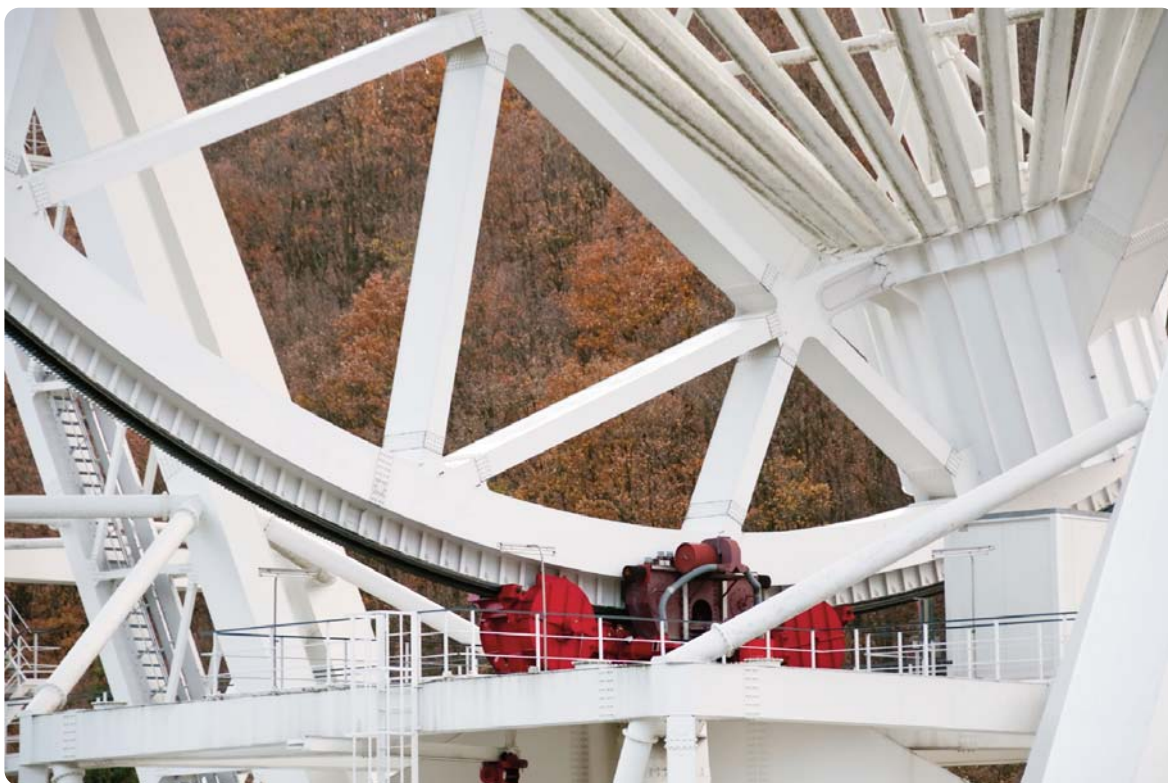
Bild 2: Antrieb, welcher das Radioteleskop mit einer Genauigkeit von 5° steuert
